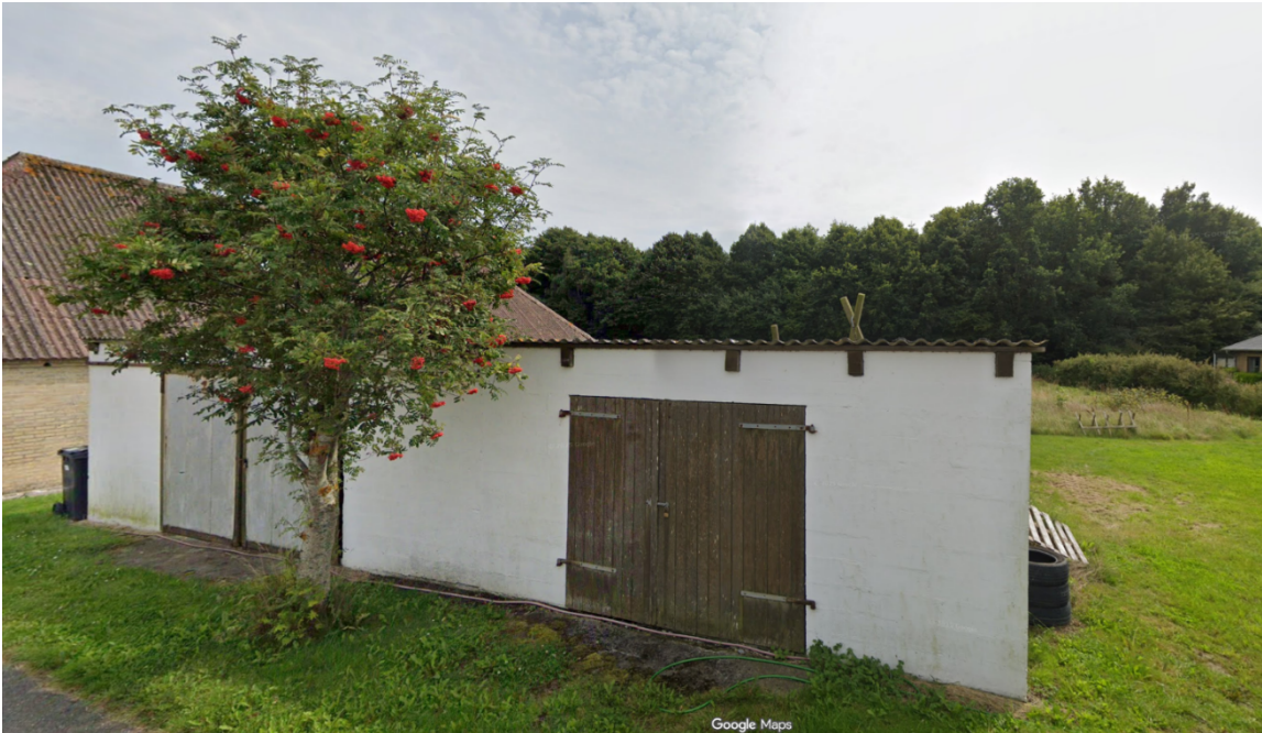
Fig. 1 – Foto af eksisterende maskinhus, der nedrives.
